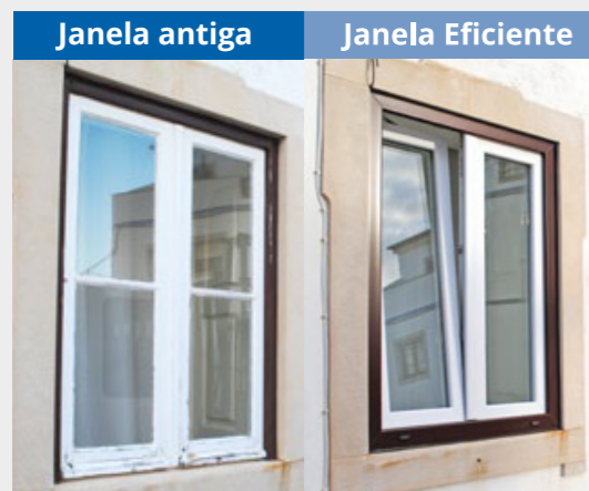
Figura 4 - Antes e depois da substituição de uma janela antiga de madeira por uma janela eficiente de PVC.
